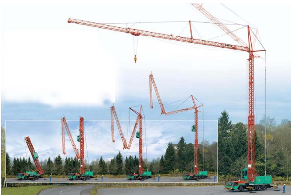
Bild 2: „Kranentfaltung“ in wenigen Minuten
